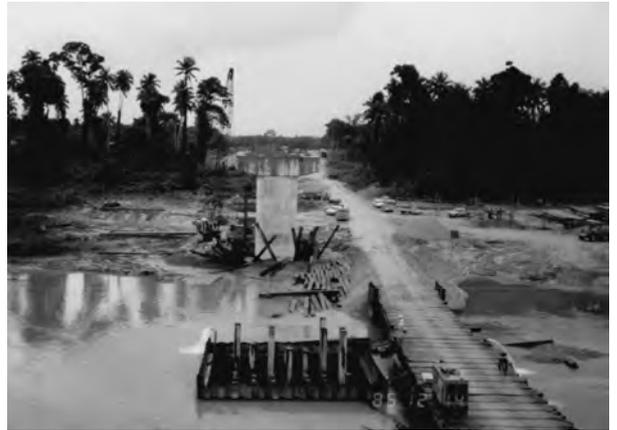
ケラントン橋の下部工事状況。下部工に使用するコンクリート杭も現場で製作しました。1995年12月撮影。
