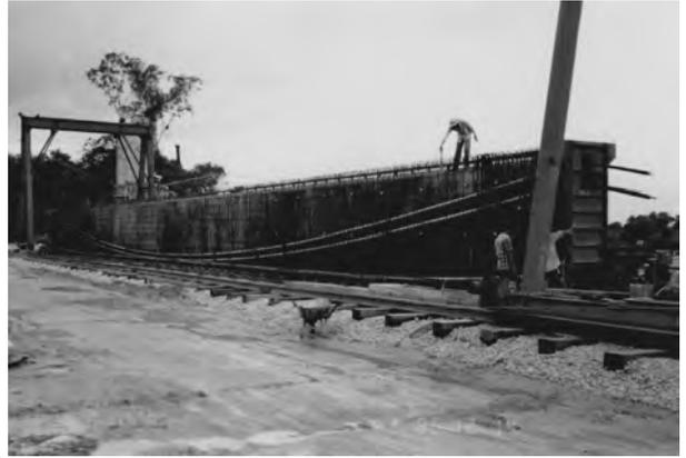
ケラントン川のタナメラというところに、680mのPC橋梁を建設しました。桁高が2.5m、桁の長さは50mもあり、当時のPC桁としては最大規模だったと思います。1995年12月撮影。
